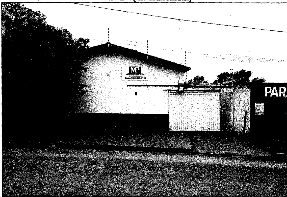
FACHADA (ÁREA EXTERNA)
