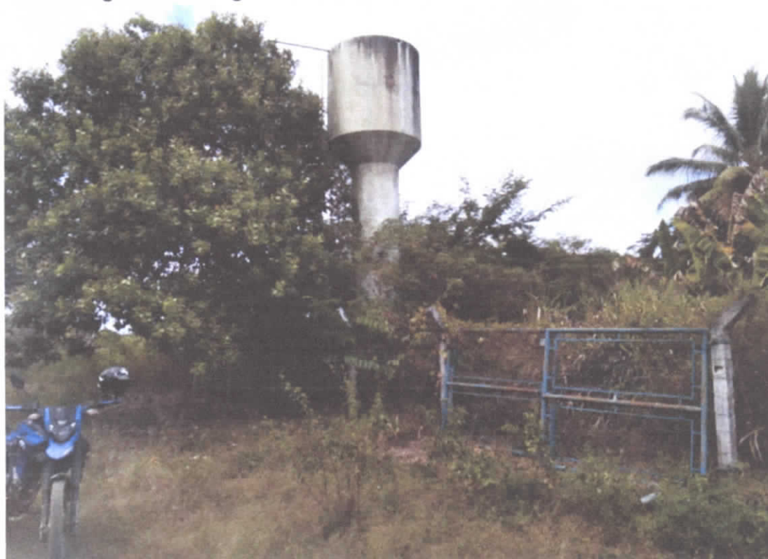
Figura 19 - Vista geral reservatório elevado do Assentamento Tobasa
