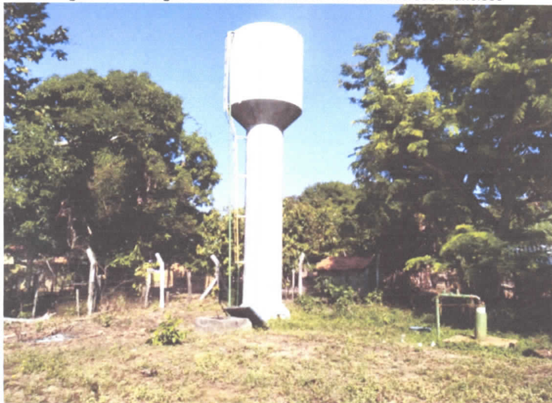
Figura 21 - Vista geral reservatório elevado do Povoado São Francisco
