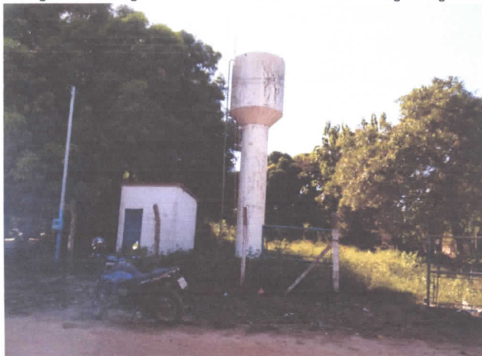
Figura 17 - Vista geral reservatório elevado do Povoado Pingo D' Água
