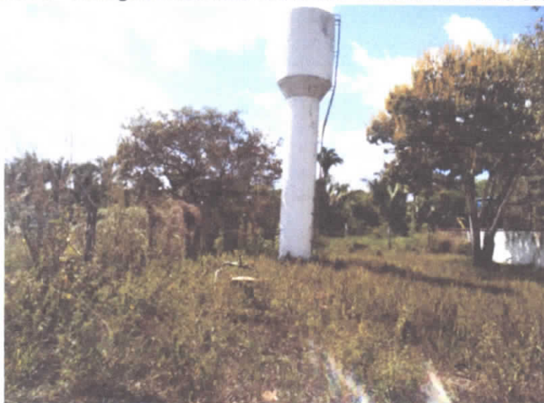
Figura 23 - Vista geral reservatório elevado do Povoado Pedra Grande
