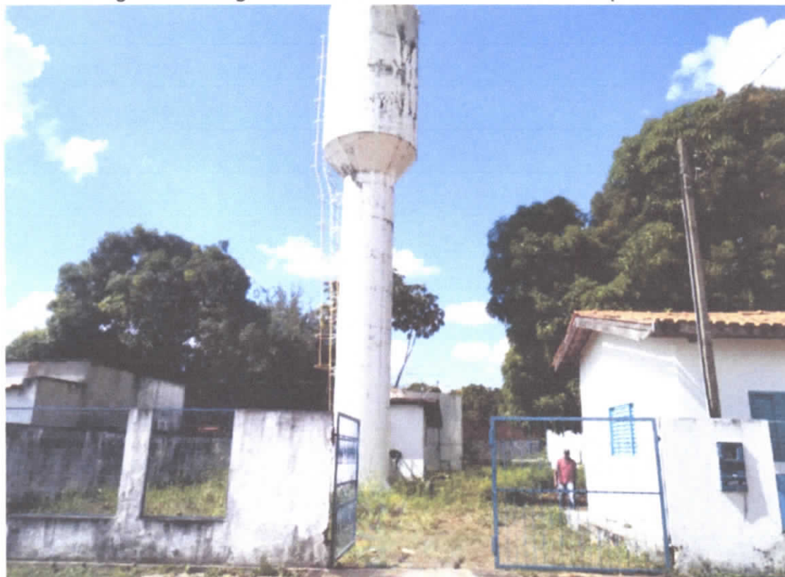
Figura 6 - Vista geral do reservatório elevado REL01 de Esperantina
