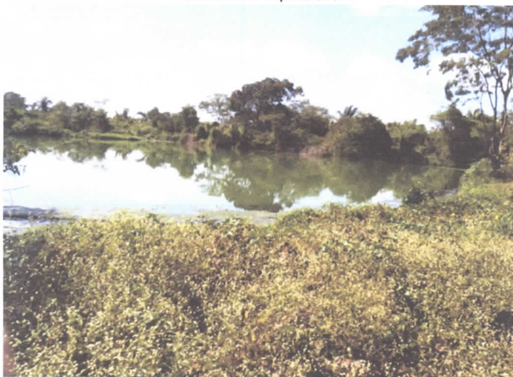
Figura 11 - Vista geral de uma lagoa de estabilização da estação e tratamento de efluentes de Esperantina
